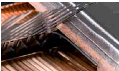
Der Traufenlüftungskamm bietet Schutz vor Vogeleintrieb.
